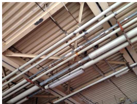
Figura 15- Particolare della lamiera protetta con vernice intumescente.
